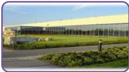
有限会社「ガーチアンガラスリヤザン」 世界最大の板ガラスとガラス製品の 製造所の一つ
